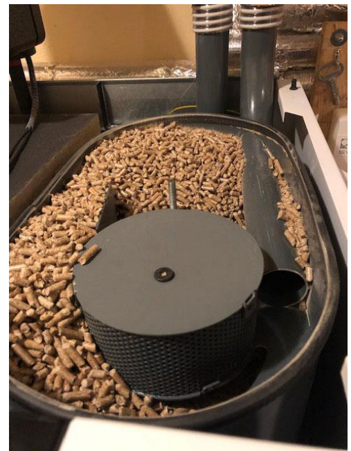
Blick in den gefüllten Zwischenbehälter mit Einlaufrohr rechts und runder Luftansaugung vorn. (Deckel abgenommen.)
