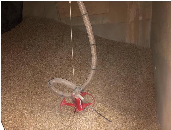
Maulwurf im Pelletlager
