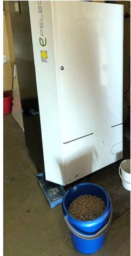
Handarbeit: Ausmessen des Zwischenbehälters mit Eimer und Kofferwaage
