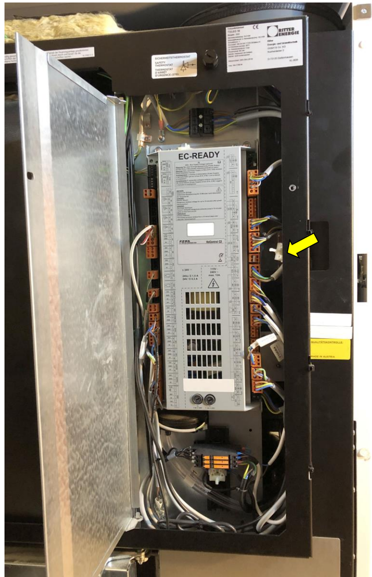
Signalkoppler unterhalb der Kesselsteuerung eingebaut. Pfeil: Sicherungshalter für Raumaustragungs-Motor
